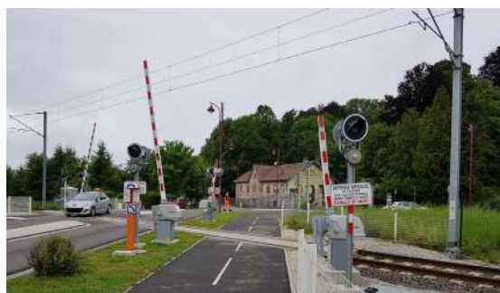
Double passage à niveau (piéton et routier)
