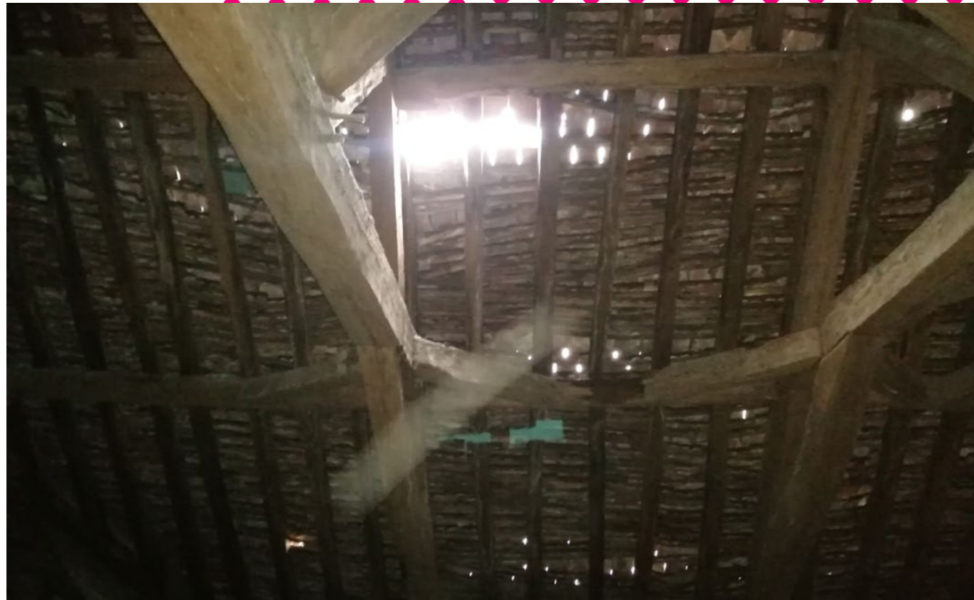
Charpente et revers d'une portion de couverture de l'église Saint-Philibert, état 2022 © Ville de Dijon
