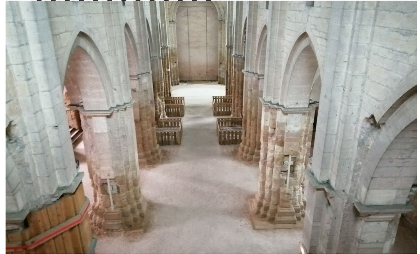
Vue de la nef depuis l'ouest, avec les dispositifs d'étaieement, état 2022 © Ville de Dijon
