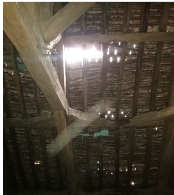
Charpente et revers d'une portion de couverture de l'église Saint-Philibert, état 2022 © Ville de Dijon
