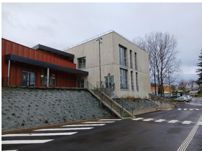
Vesoul (Haute-Saône) – Lycée polyvalent Edouard Belin/Legta Étienne Munier : construction du service commun de restauration et de logements de fonction – Coût de l'opération : 11 700 000 € – Réceptionnée en octobre 2024
