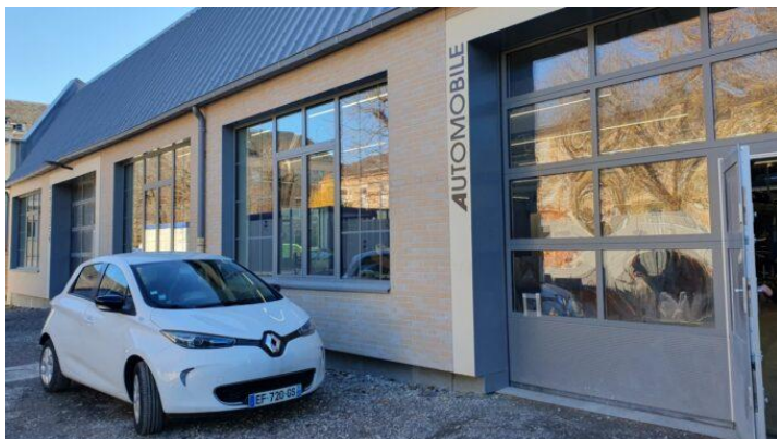
Dijon (Côte-d'Or) – Lycée polyvalent Hippolyte Fontaine : restructuration des ateliers maintenance automobiles (bâtiments F et B) – Coût de l'opération : 6 800 000 € – Réceptionnée en décembre 2024
