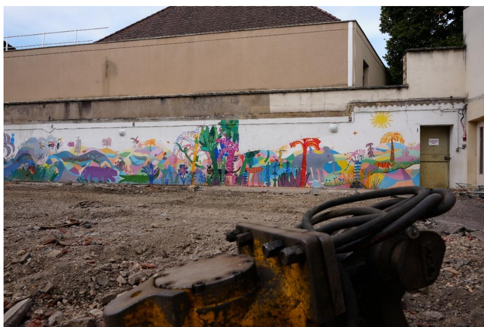
Lancement du chantier de rénovation de l'école maternelle Joséphine BAKER / ©Christian Dubarry-Ville de Dijon
